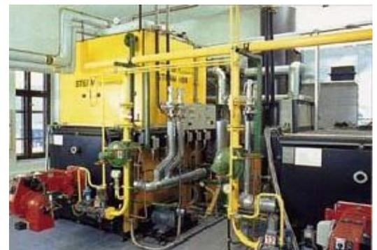
газовые парогенераторы STEAM 2 x 2000 кг/час в цехе производства ликеро-водочной продукции
